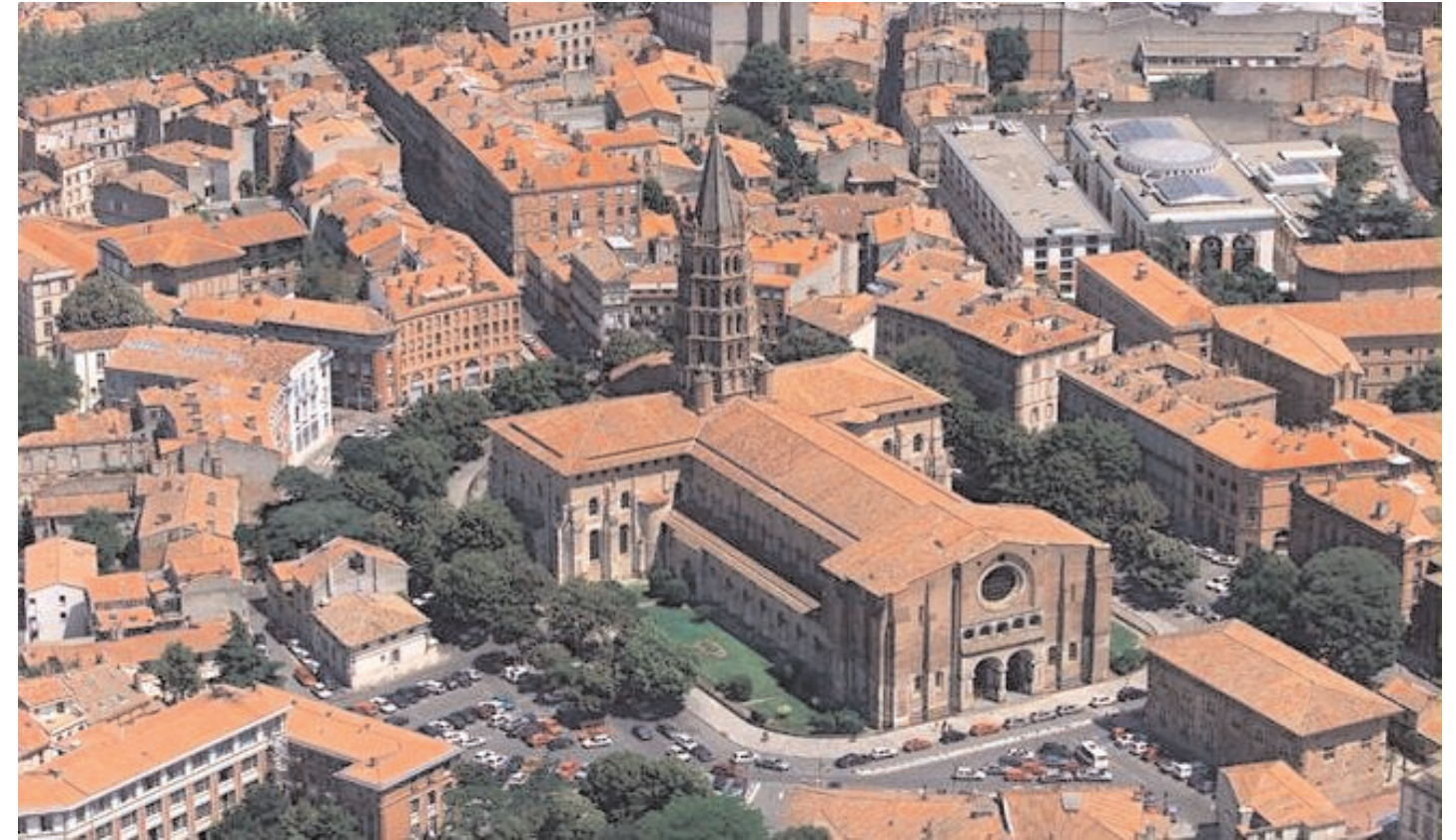
la basilique vue du sud-ouest
